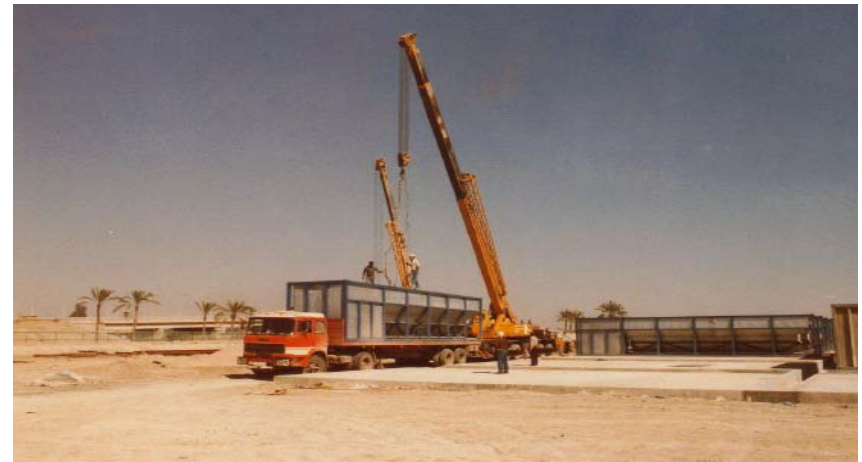
Momento de Instalaciòn
